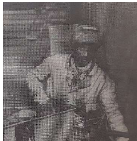
Als monteur bij staalconstructiebedrijf De Groot
